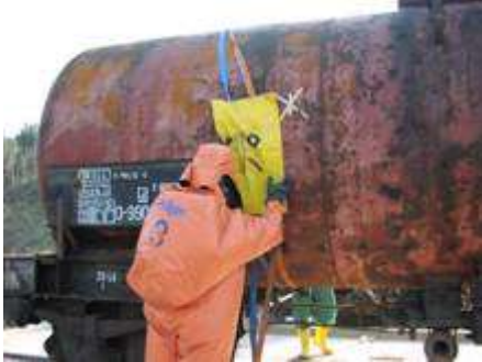
Slika 11: Tesnilna blazina (Gasilsko reševalna služba Jesenice)
