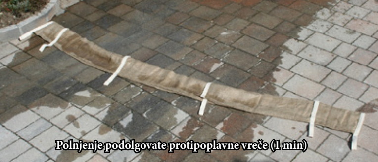
Polnjenje podolgovate protipoplavne vreče (9 min)
